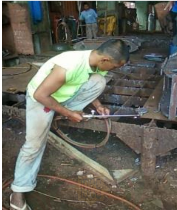
Gambar 5 Posisi kerja membungkuk yang berisiko mengalami keluhan MSDs pada pinggang, tangan, dan kaki
