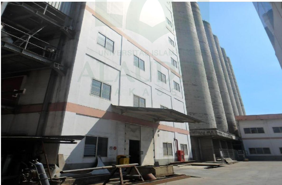
Keterangan: Gedung dengan jendela tertutup (Workshop dan Packing)
