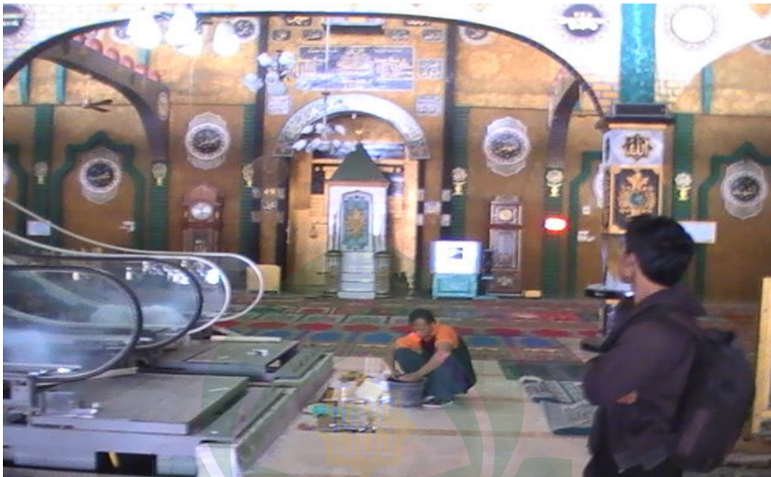
Gambar: 5 Foto seorang pekerja tengah memperbaiki bagian lantai yang rusak
