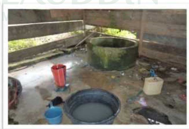
Gambar 7. Kondisi Jaringan Air Bersih
