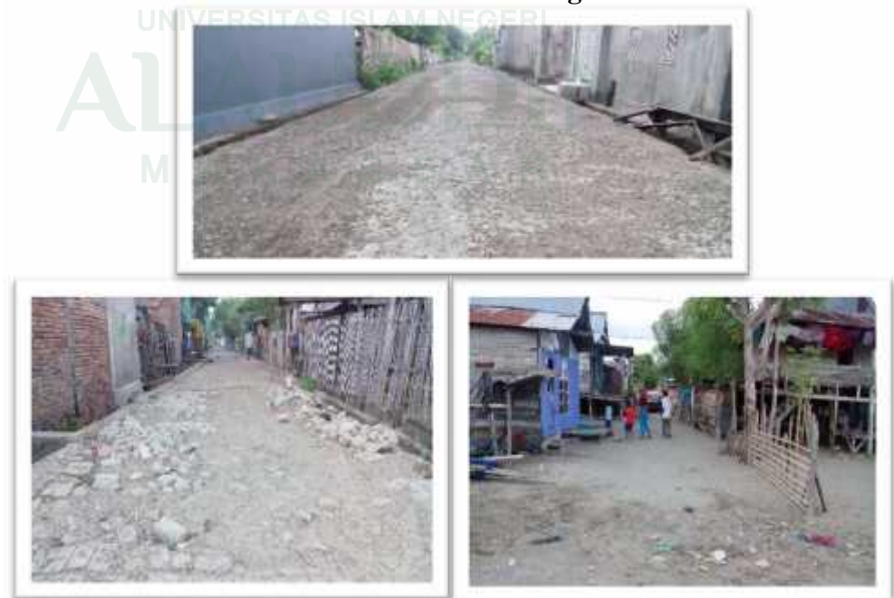
Gambar 5. Kondisi Jaringan Jalan
