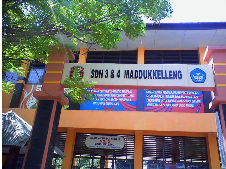
Gedung SDN 4 Maddukkelleng Kab. Wajo
