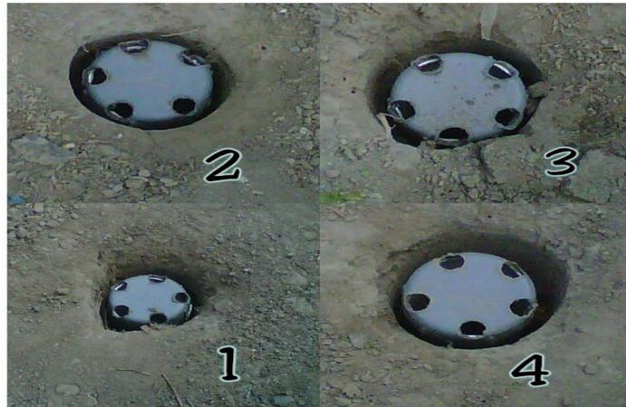
Gambar 3.2: Mulut lubang resapan dengan dob
