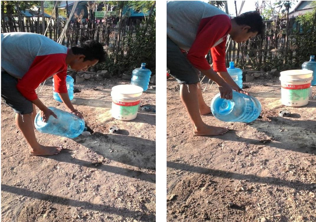
Gambar L.9: Proses pengisian air pada lubang resapan biopori
