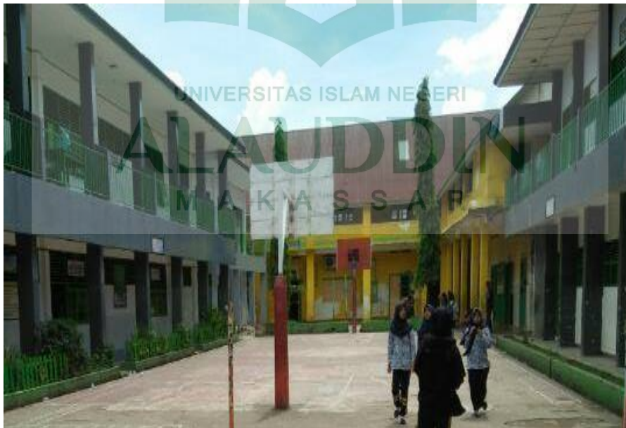
Madrasah Muallimin yang terletak di Jalan Muhammadiyah, Makassar. Salah satu bukti nyata kepemimpinan KH. Abdullah pada masa jabatannya. Terlihat dari bangunan Madrasah tersebut, dapat disimpulkan bahwa telah mengalami renovasi.
