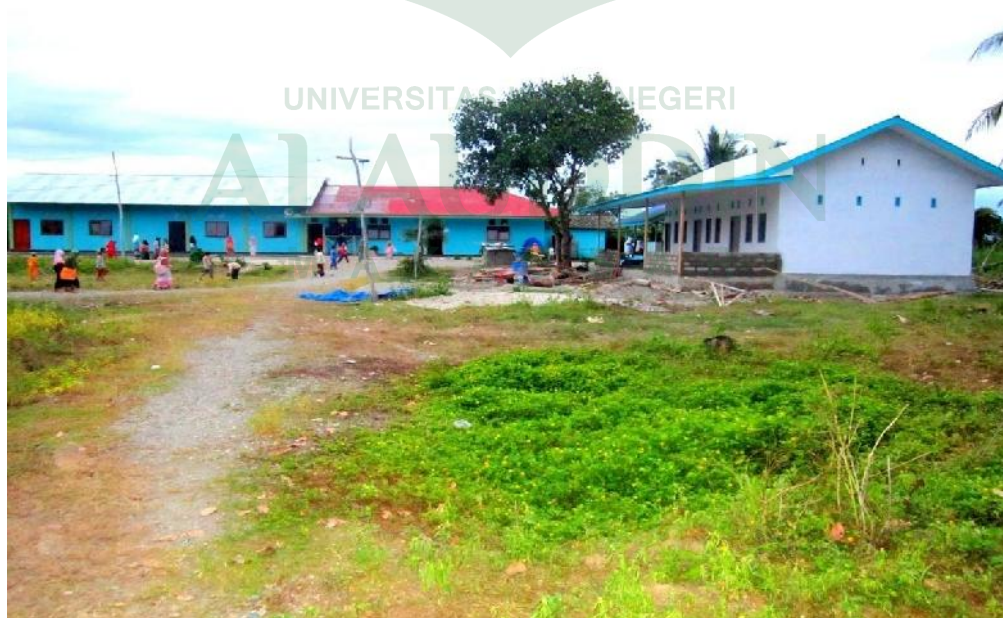
KONDISI BANGUNAN PON PES AL-FALAH
