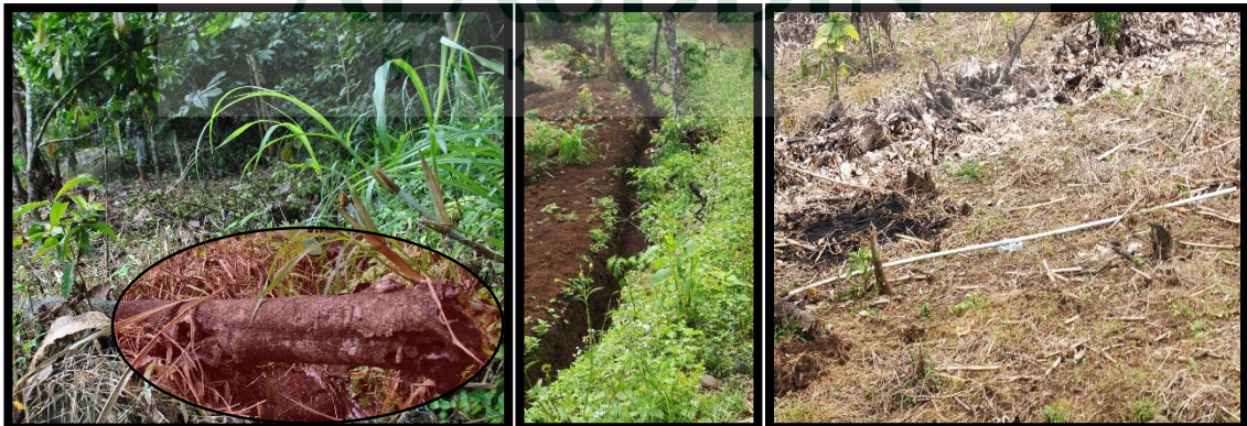
Sungai Kecil yang dijadikan sarana BABS oleh Masyarakat (kiri), saluran drainase (tengah) dan Perpipaan Distribusi Air Bersih (kanan)
