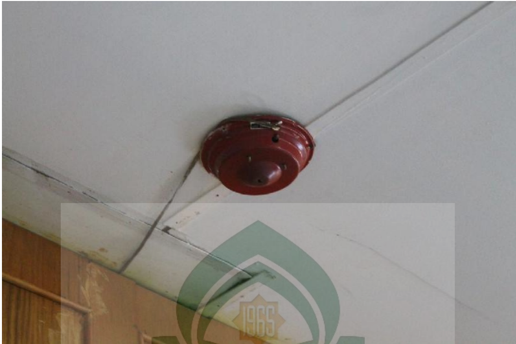
9. Alarm ketika terjadi Bencana Kebakaran
