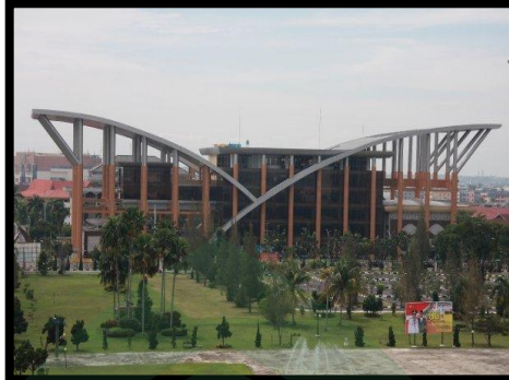
Gambar. II. 31. Tampak depan perpustakaan Soeman Hs (sumber: www.kaskus.us )
