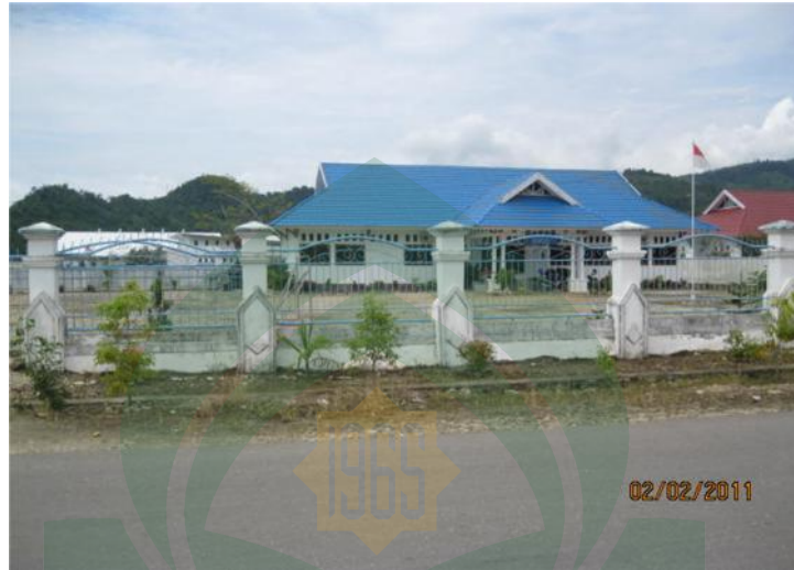
Gambar Fasilitas Perkantoran di Kecamatan Lasusua
