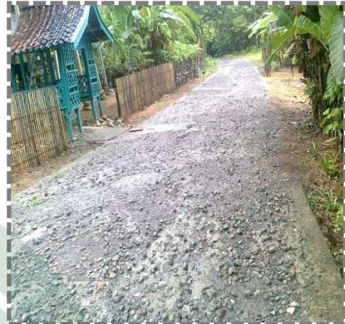
Gambar 11: kondisi Jalan pengerasan
