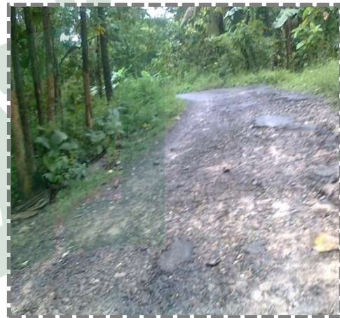
Gambar 13: kondisi Jalan pengerasan
