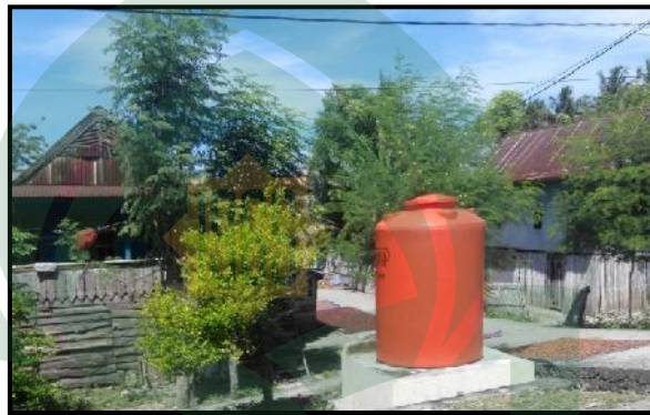
Gambar 8. Tempat Penampungan Air yang Bersumber dari Sumur
