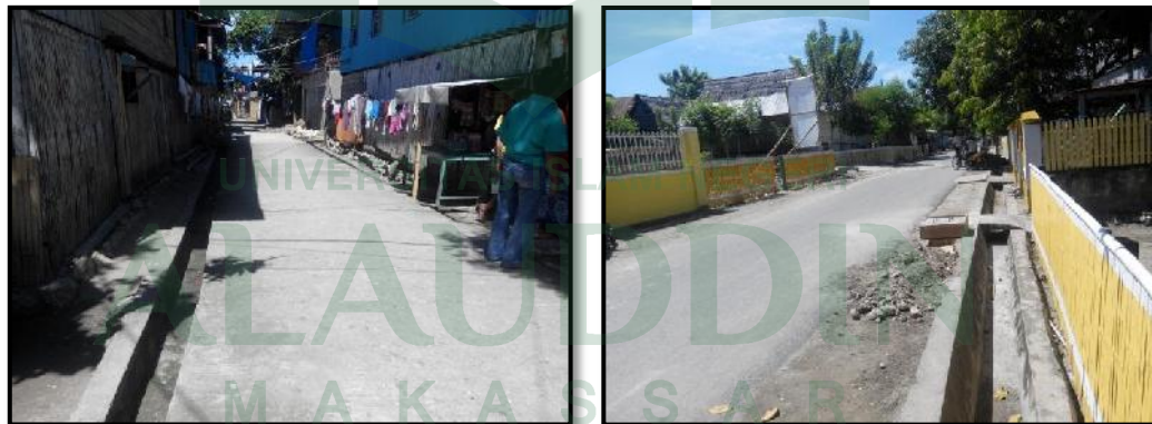
Gambar 7. Jaringan Drainase di Lokasi Penelitian
