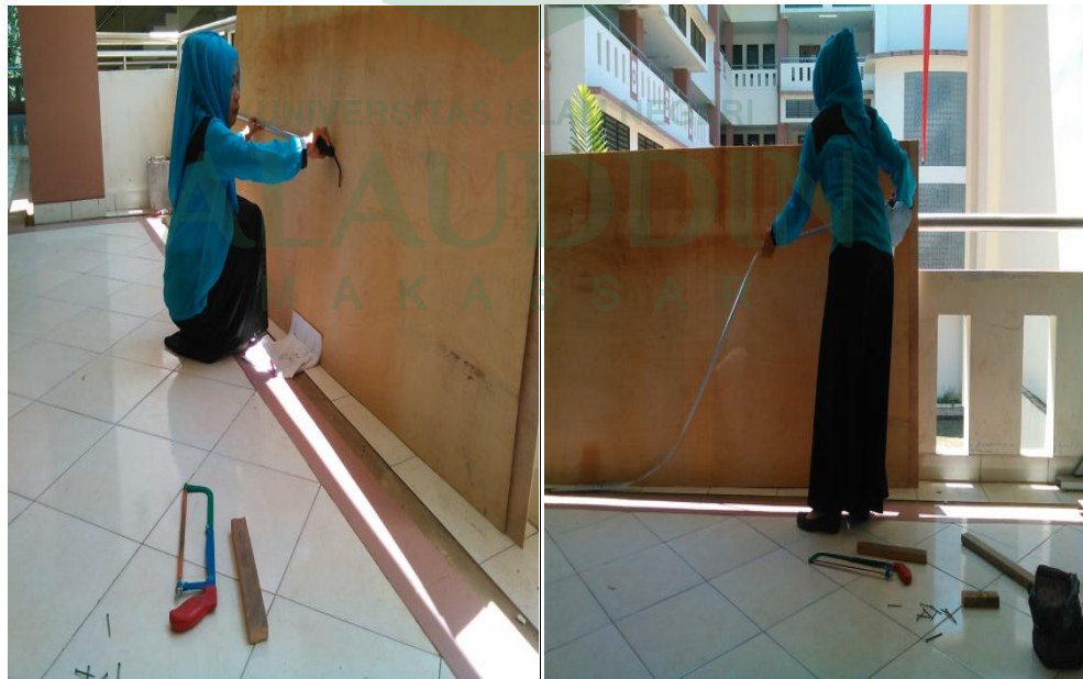
Gambar 3.2 Proses Pengukuran Dinding Layar Sebelum Dilubangi
