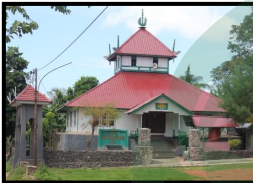
Bangunan masjid tertua di kab. Wakatobi
