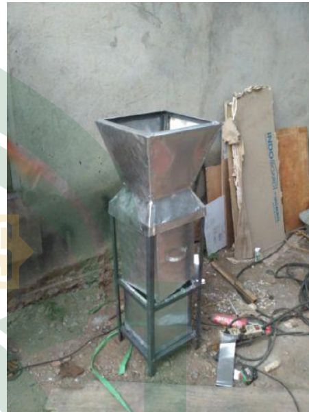
Gambar L.23 Pemasang dinding rangka
