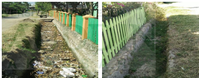
Gambar 4.32 Kondisi Drainase kampung Tekolabbua RW 01.
