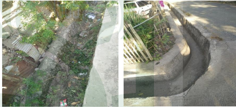
Gambar 4.64 Kondisi drainase kawasan kumuh Turun Pissuei.
