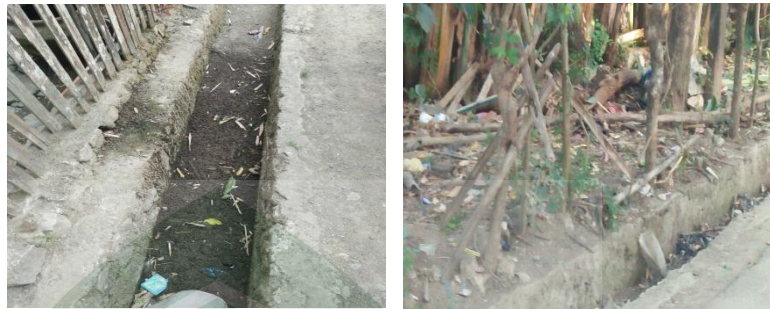
Gambar 4.56 Kondisi drainase kawasan kumuh Bonto Labbere.
