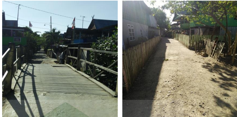
Gambar 4.48 Kondisi jalan kawasan permukiman kumuh kampung padaedae bulu bulu Kelurahan Arong Appaka
