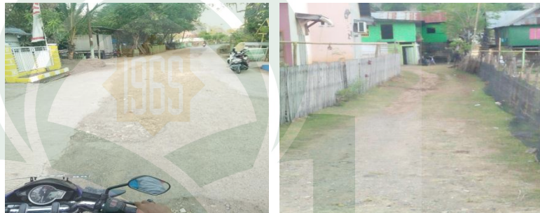
Gambar 4.38 Kondisi Jalan Lingkungan kawasan kumuh kampung Biraeng
