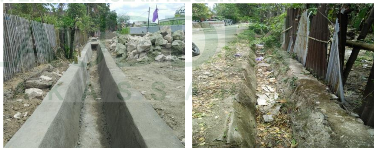
Gambar 4.73 Kondisi drainase kawasan kumuh Bonto Perak.
