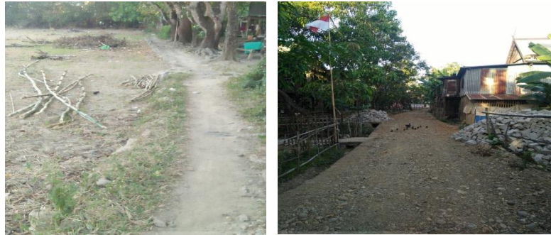
Gambar 4.54 Kondisi jalan kawasan kumuh Bonto Labbere.
