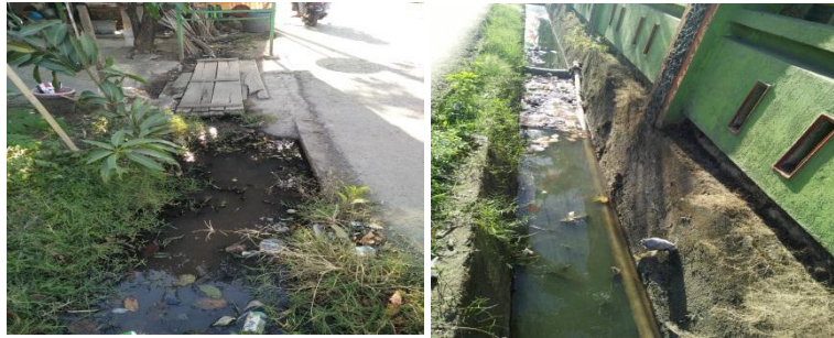
Gambar 4.4 Kondisi Drainase Kampung Lette Sumber : Survey Lapangan 2017
