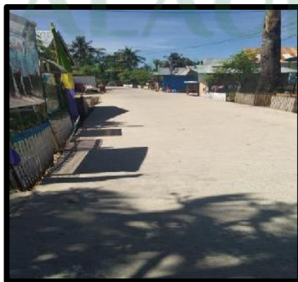
Tidak ada Drainase
