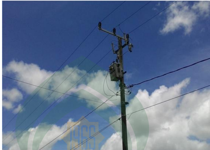
Gambar 16. Jaringan listrik di Kecamatan Tiworo Selatan
