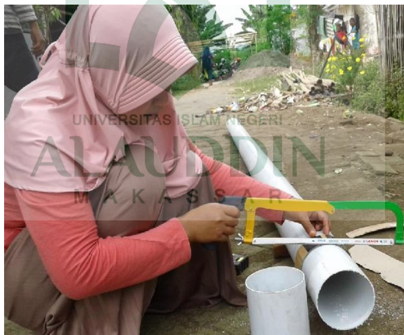
Gambar 5 : Proses pemotongan pipa ukuran t : 15 \text{ cm} , d : 10 \text{ cm}
