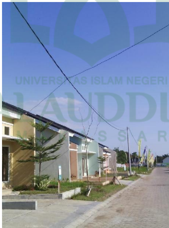
Jaringan tiang ke tiang di Blok AA
