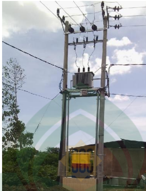
Trafo yang terdapat di perumahan
