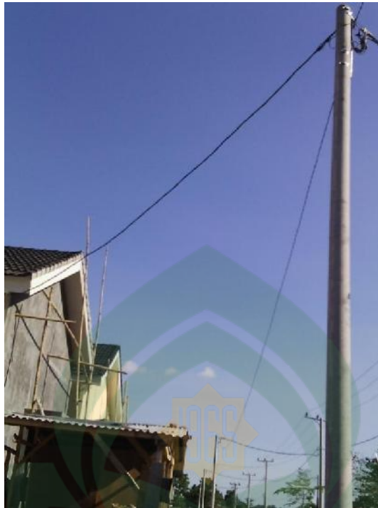
Kabel dari Tiang 9 ke rumah
