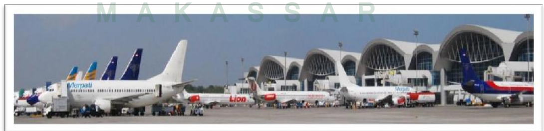
Gambar 3 : Foto Fasilitas Sisi Udara
