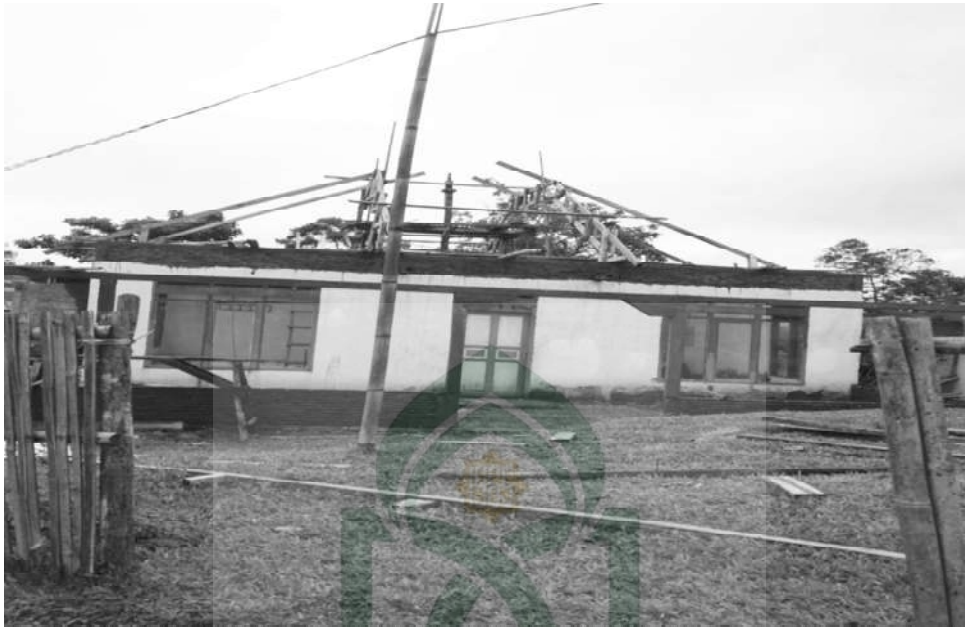
Foto 4: Masjid yang sedang dalam pekerjaan renovasi di Borongbulo
