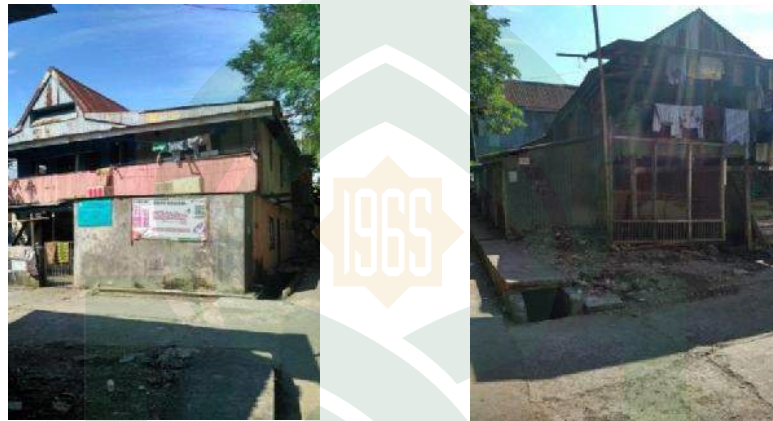
Gambar 4.2 Kondisi bangunan dilokasi penelitian
