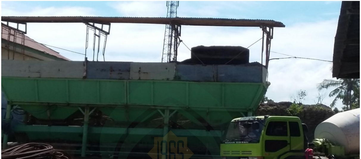
Memasukkan Bahan Baku Ready Mix Kedalam Truck Mixer Untuk Melakukan Pencampuran atau Pengadukan
