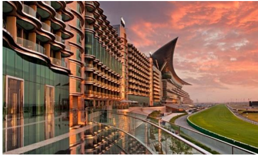
Gambar 2.18, tampak bangunan Dubai Luxury Racecourse 'Meydan' Sumber: www.kwicollection.com , diakses tanggal 9 mei 2016
