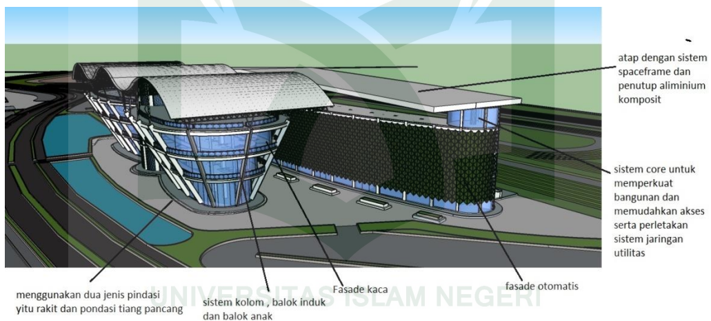
Gambar 6.16, struktur dan material banguna utama Sumber: Hasil Desain, November 2017.
