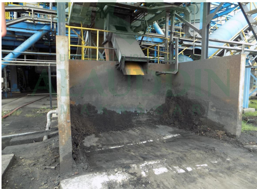
Gambar 9. Penampung Bottom ash dari boiler D pada BTG 2 × 35 MW
