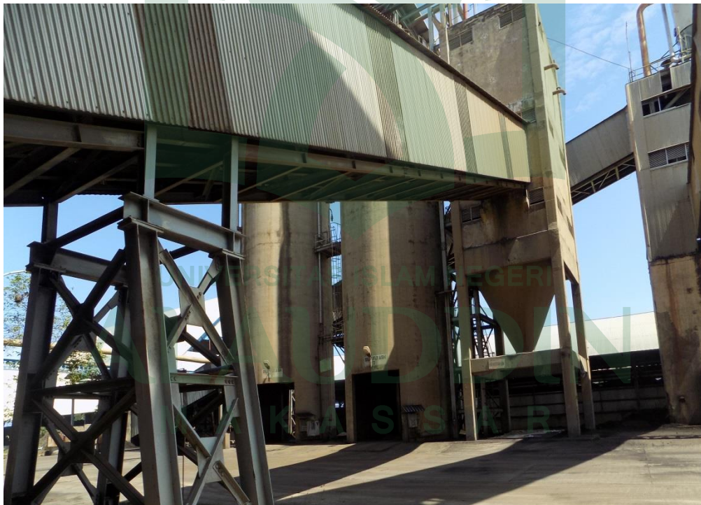
Gambar 4. Penampung fly ash Silo 1 dan Silo 2 dan penampung bottom ash
