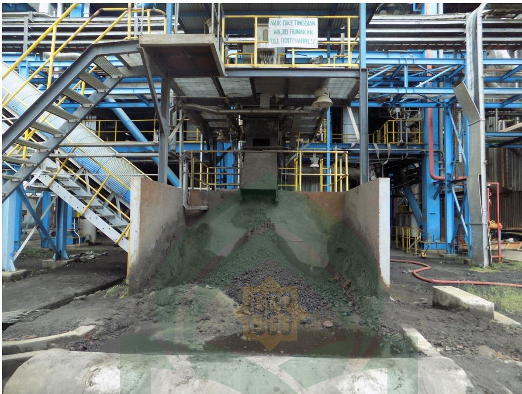
Gambar 6. Penampung bottom ash dari boiler C pada BTG 2 × 35 MW
