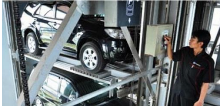
Gambar II.24 Gedung Parkir Rumah Sakit Cipto Mangunkusumo (Sumber: www.tempo.co Diakses pada tanggal 30 maret 2015)
