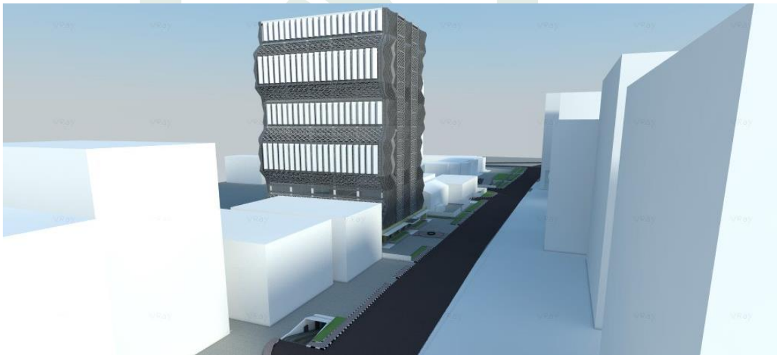
Gambar VI.9 tampak bangunan timur (Sumber : Olah Desain, 24 November 2015)
