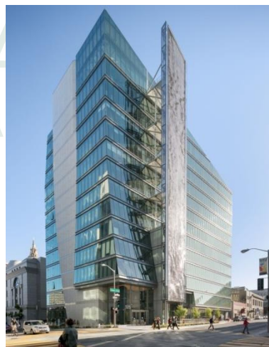
Gambar II.19 Al hamra (Sumber: Arcdaily, diakses pada tanggal 28 april 2015)
