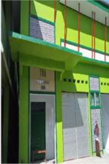
Gambar 7 : Ruang Praktek Jurusan Teknik Kendaraan Ringan SMK Latanro Ekg
