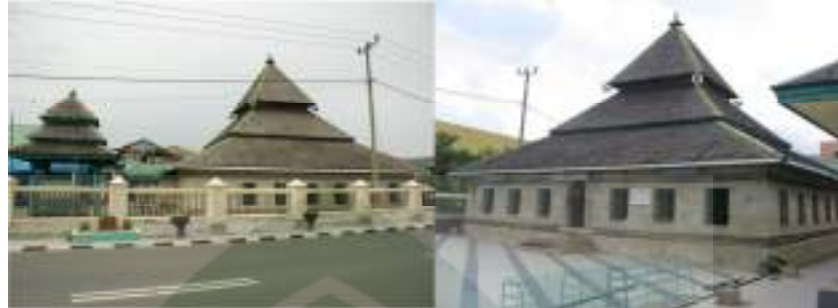
Gambar II. 11 Tampak Samping dan belakang Masjid tua Palopo (sumber : https://www.google.co.id/Webhp?sourceid=chrome-instant&ion=1&espv=2&ie=UTF-8#q=arsitektur%20masjid%20tua%20palopo , di akses tanggal 2 Mei 2015)
